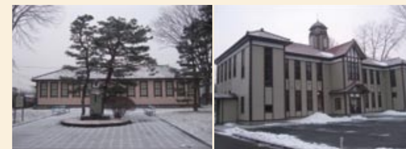
左は1899年に建てられた臨時緯度観測所。現在は「木村記念館」として公開されている。右は緯度観測所旧本館。宮沢賢治がアイデアを育んだとされる。現在は奥州市の「奥州宇宙遊学館」として、天文学・宇宙科学の一般普及の場として利用されている。
