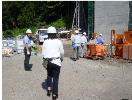
建設中のハツ場ダムサイト視察（橋脚）の様子
