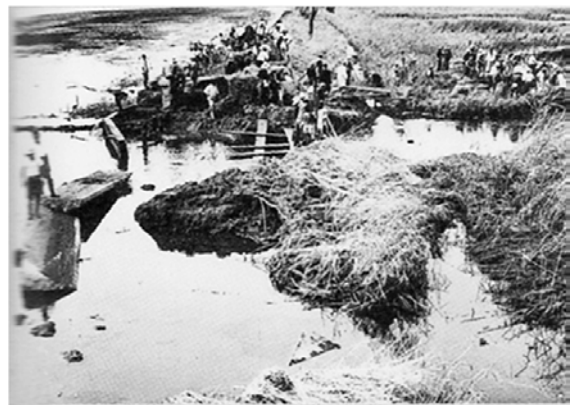
写真1 昭和24年キティ台風で決壊した土堤 提供 浦安市郷土博物館
