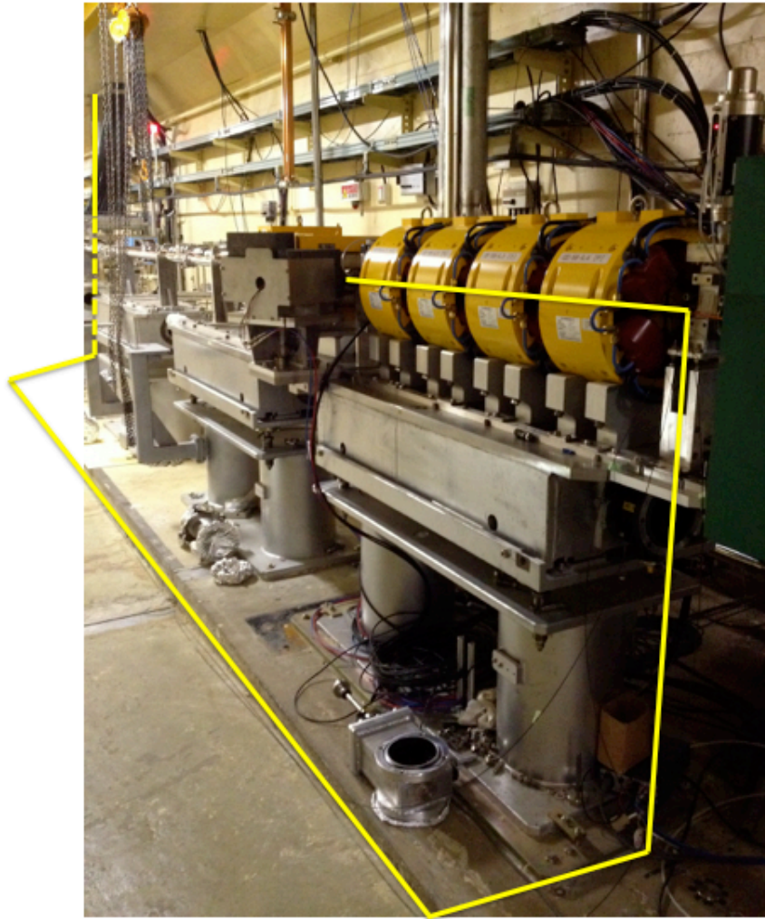
図 7.5.1 : 分岐ダクトでのビームロス进行る布設経路の写真。
