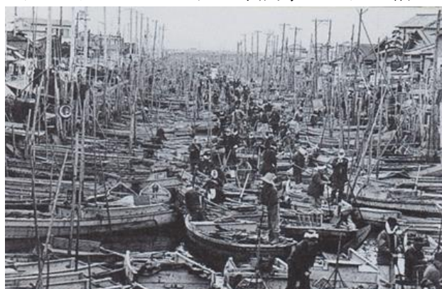
写真 2-1-5 昭和30年頃の江川橋付近
