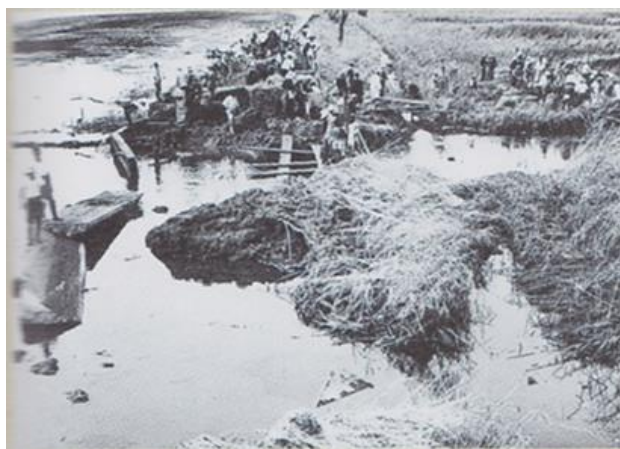
写真2-1-2 昭和24年 キティ台風で決壊した土堤 浦安市郷土博物館蔵
