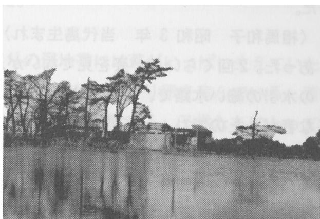
写真 2-2-10 堀江地区の地盤沈下
