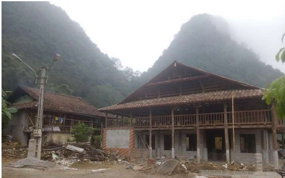
写真 1-11 : 改造中のパクラン村の高床式住居 (2013 年)
