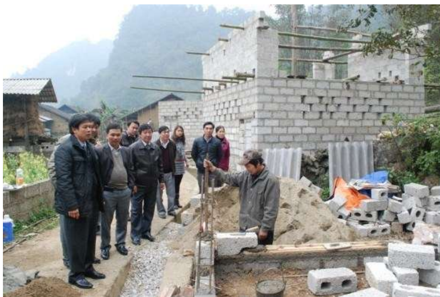
写真 3 - 6 : 各家の前に建設中の家畜小屋、ブロック煉瓦造りである（2012 年）
