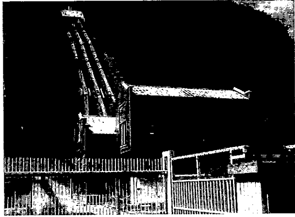
図9 東京電力丸守発電所(筆者撮影)
