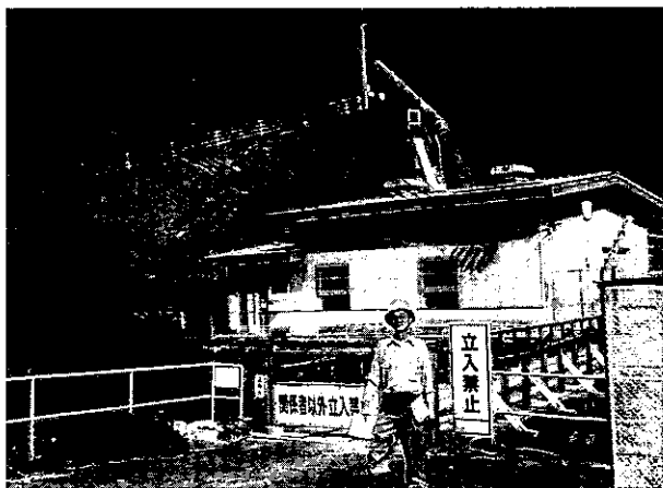
図10 東北電力雨谷発電所(筆者撮影)
