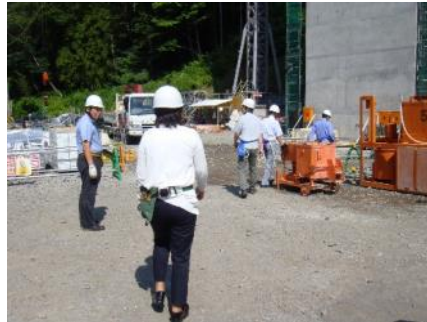
建設中のハツ場ダムサイト視察（橋脚）の様子
