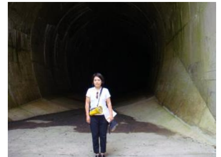
巨大な排水トンネル前で写真を撮る筆者
