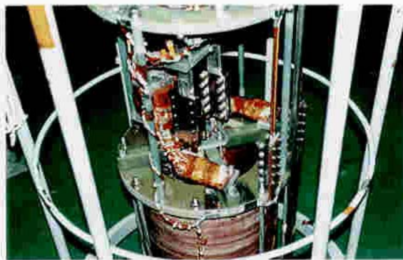
(c) バックアップマグネットに取付けたところ
