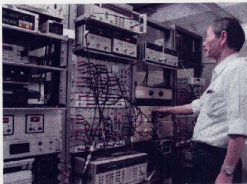
図 5.5 RF パワー制御盤
